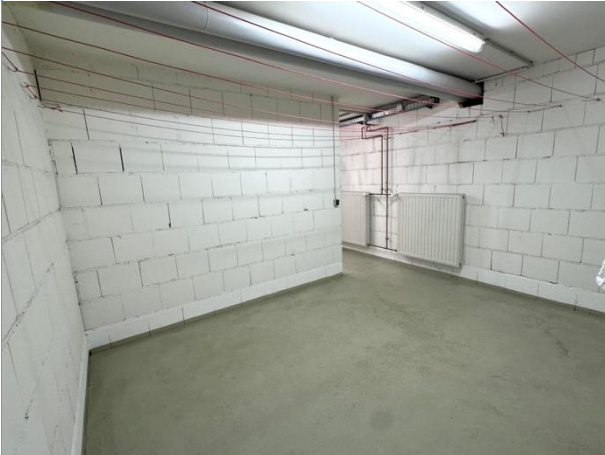
Gemeinsamer Trockenraum neben Waschsalon
