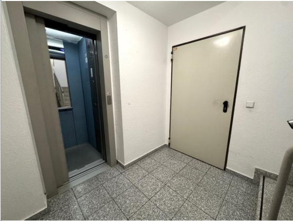
UG-Treppenhaus inkl. Aufzug
