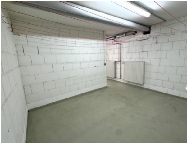
Gemeinsamer Trockenraum neben Waschsalon
