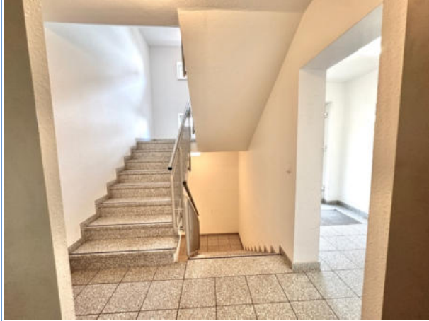
EG-Treppenhaus (Blick aus Aufzug)
