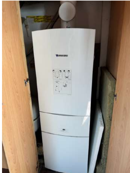
Gasbrennwerttherme Junkers
